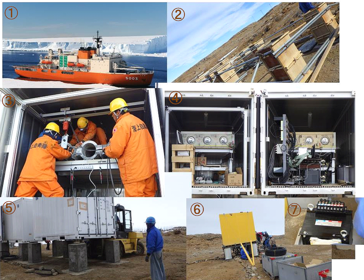
▲写真①：砕氷艦しらせ(海自 HP より)、写真②：基礎工事(コンテナを載せる基礎作り)、写真③：検出器の組付作業、写真④：設置した宇宙線観測装置、写真⑤：コンテナを基礎に据付ける、写真⑥⑦：電源工事(コンテナへの電源ラインを引く、⑦はトランス)
