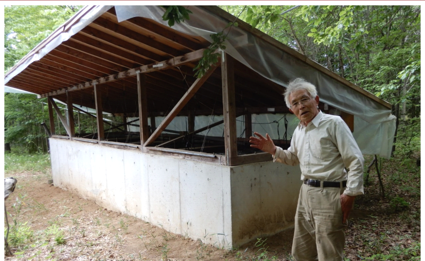
① バイオ浄化槽（4槽直列）の全景（コンクリートの基礎以外は自作）
